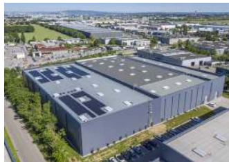
Panneaux photovoltaïques installés sur le site Émile Maurin à Saint-Priest (69).
